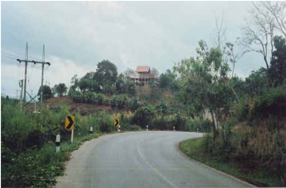
รูปที่ 6.24 บ้านพักที่กำลังก่อสร้างบนพื้นที่สูงชัน อำเภอแม่จัน จังหวัดเชียงราย
