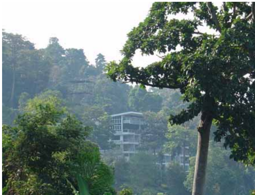
รูปที่ 6.44 การก่อสร้างอาคารบนภูเขา
